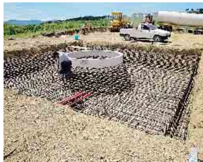
L'incontro del comitato di Nicelli contro il parco eolico; a destra la pala già esistente nella frazione e il particolare dell'allestimento della base. «L'Aserei sarebbe riempito di calcestruzzo - dichiara il comitato - perché ogni pala deve essere sostenuta da 200 metri cubi di cemento, 25 betoniere di materiale». (foto Lunini)
